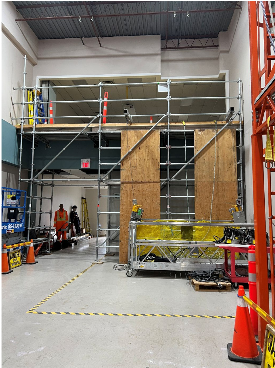
図-3.1 スイングステージ訓練設備および confined space rescue（閉鎖空間救助）訓練設備
