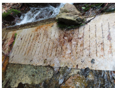
写真2 大吉寺 スクリーンと原水槽
