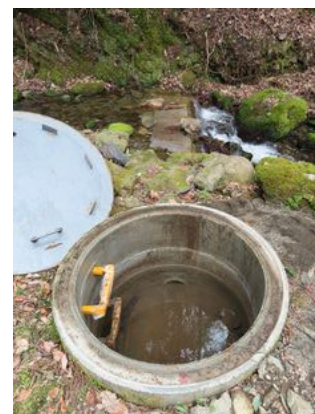
写真2 大吉寺 スクリーンと原水槽
