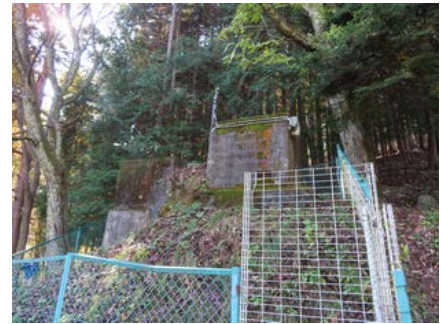
写真 3 大仏飲料水供給施設 3 つ目最古の配水池
