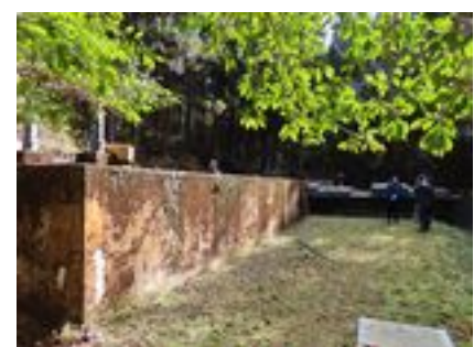
写真 8 振草浄水場 手前が普通沈殿池、奥が覆蓋 付き緩速ろ過池
