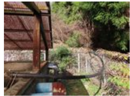
写真9 桑原浄水場 導水管から緩速ろ過池に直接注入されている
