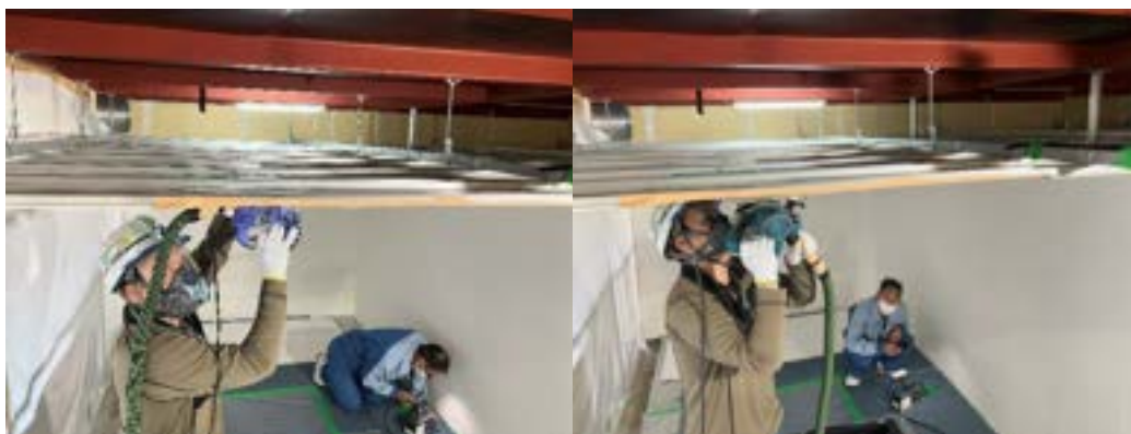
図 25 天井板を模した切断作業の状況
