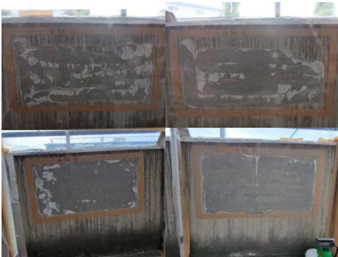
図 13 仕上塗材除去後の外観
