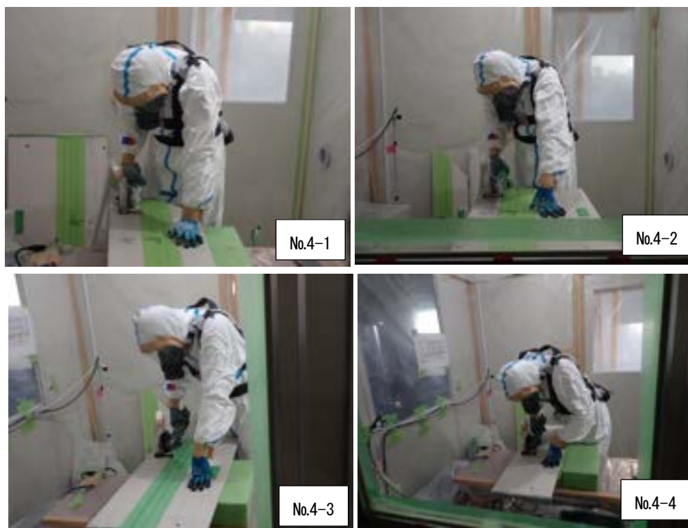
図 18 切断作業実施状況（石綿含有けい酸カルシウム板第一種、二日目）
