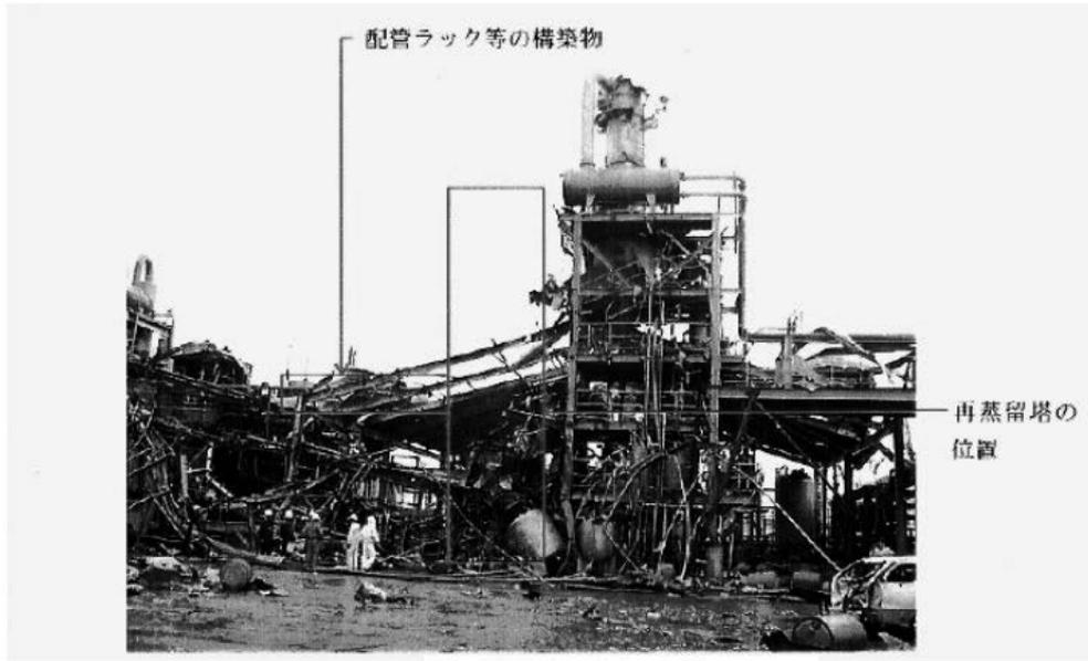
図 3 被災後の再蒸留塔近傍
