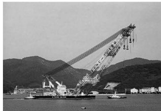
図 23 浮きクレーン
