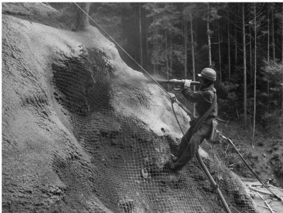
写真-3 吹付工施工状況
