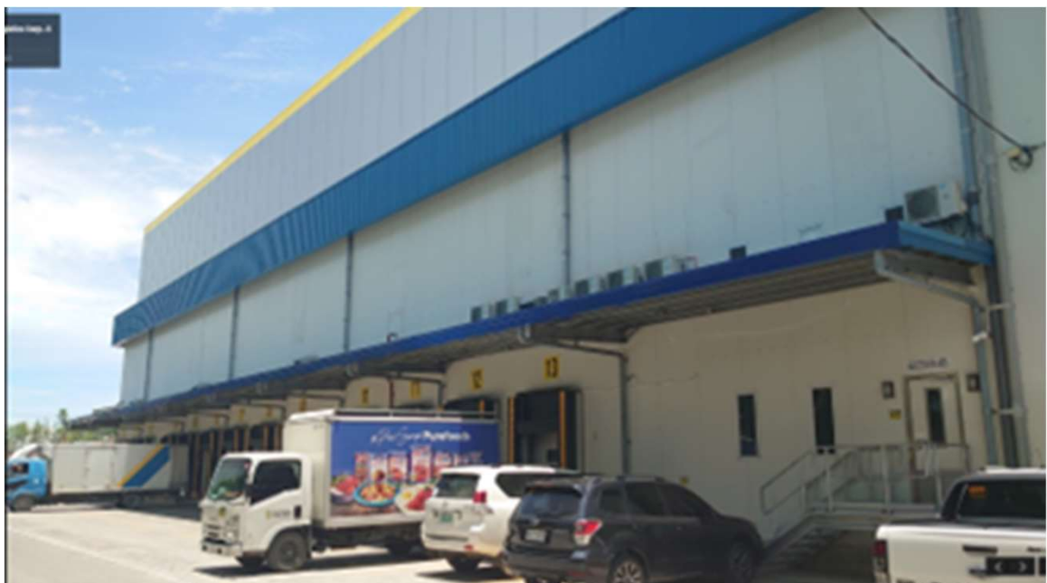
写真3-1：冷凍配送会社外部
