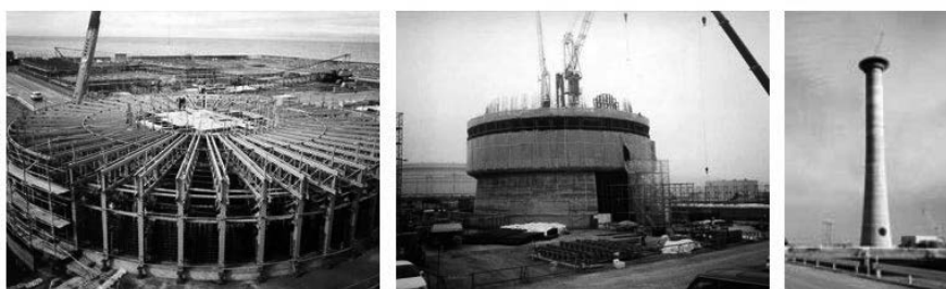
スリップフォーム装置の組立 コンクリート打設スタート 頂部コンクリート工事中
