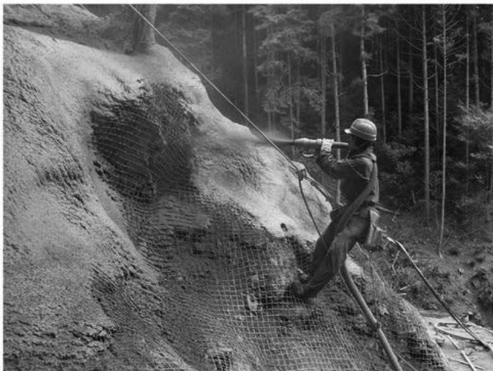
写真-3 吹付工施工状況
