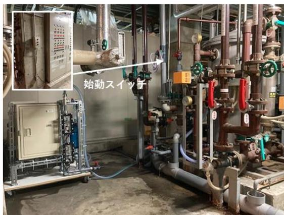
図4 オゾン供給装置設置状況
