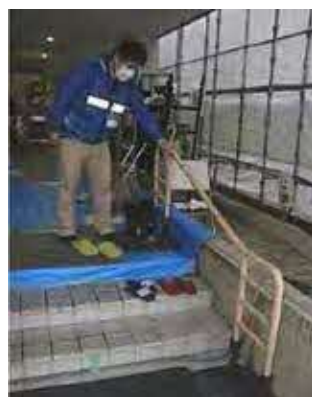
写真⑥ 手すりの設置
