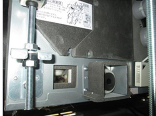
写真2. 4-1 天井内に設置された空調機の例
