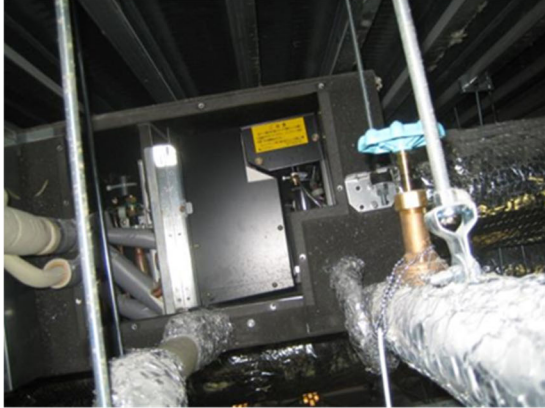
写真2. 4-1 天井内に設置された空調機の例
