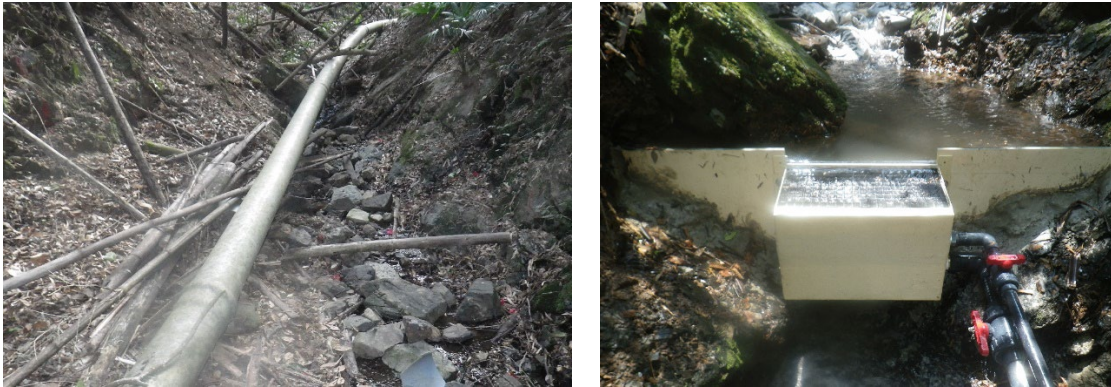
図 37 工事困難な場所での設置例（左図：着工前，右図：完成後）
