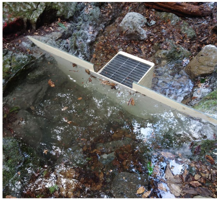
図 36 FRP 取水堰・集水弁設置事例（大分市 K 地区）
