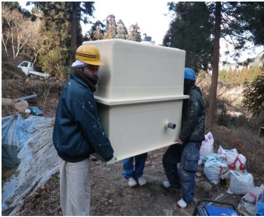
図 34 FRP 製ろ過ユニット設置状況
