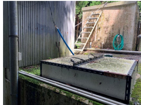
写真5 小規模向け凝集ろ過装置及び水位計を設置した覆蓋
