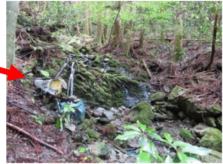
写真1 水源地と取水桝
