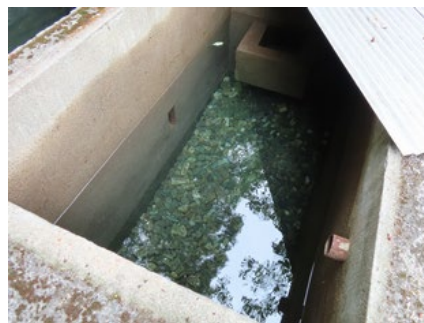
写真 8 ろ過砂が撤去されたろ過槽
