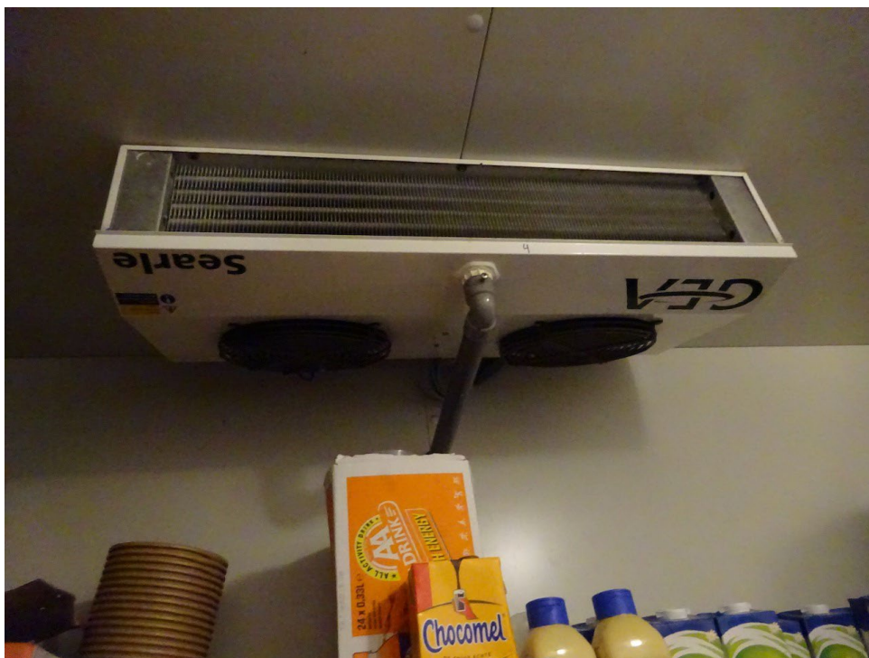
写真 2 3：冷蔵庫の換気扇に埃が溜まっていることを指摘。
