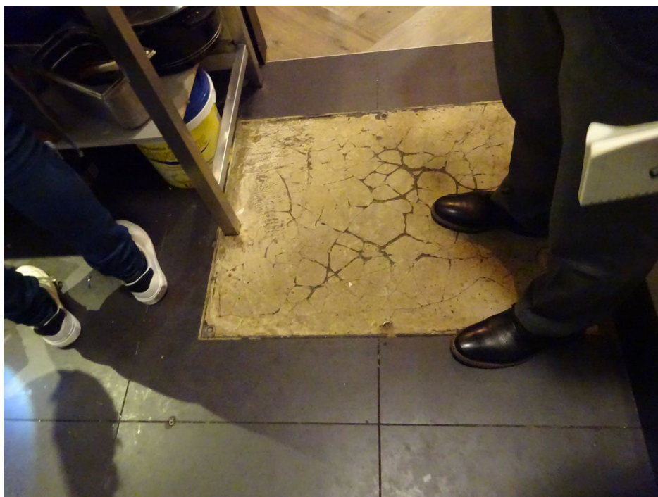
写真１７：床のタイルが割れていて水洗いができないので修理するよう指示。
