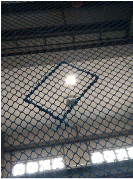
図5 部分的に補修がなされた箇所
