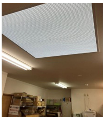
明かり取り窓付き天井
