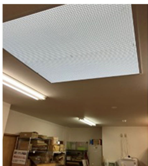
明かり取り窓付き天井
