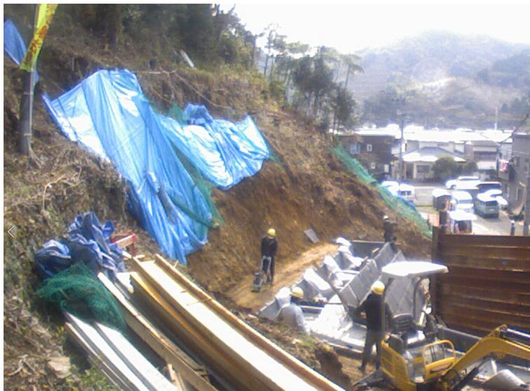
写真-8 擁壁背後の埋戻し土砂の転圧作業の状況
