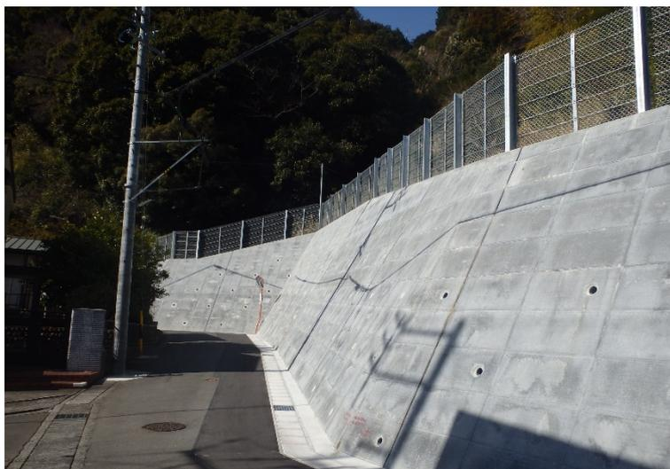
写真-1 残存型枠を用いた擁壁工（完成）
