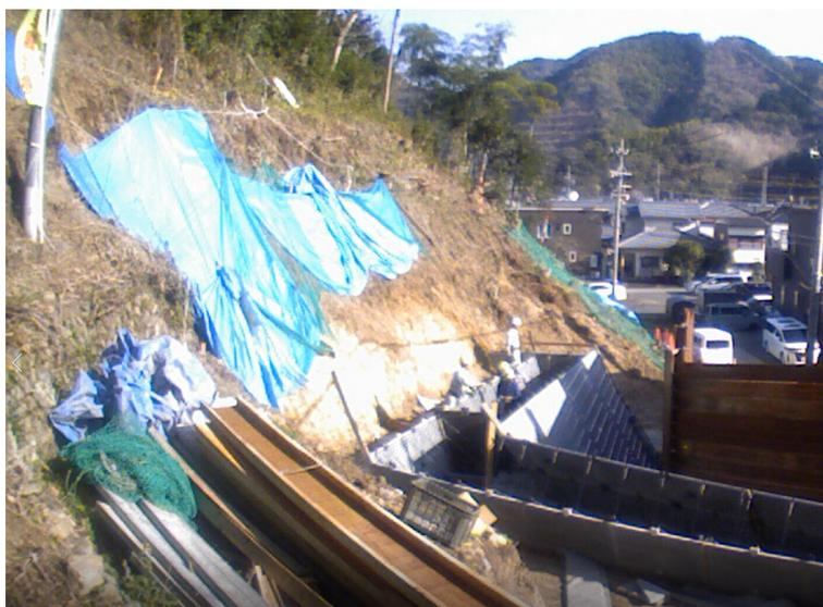
写真-9 埋戻し後の型枠組立て作業
