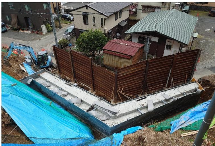
写真-2 残存型枠を用いた擁壁工施工中
