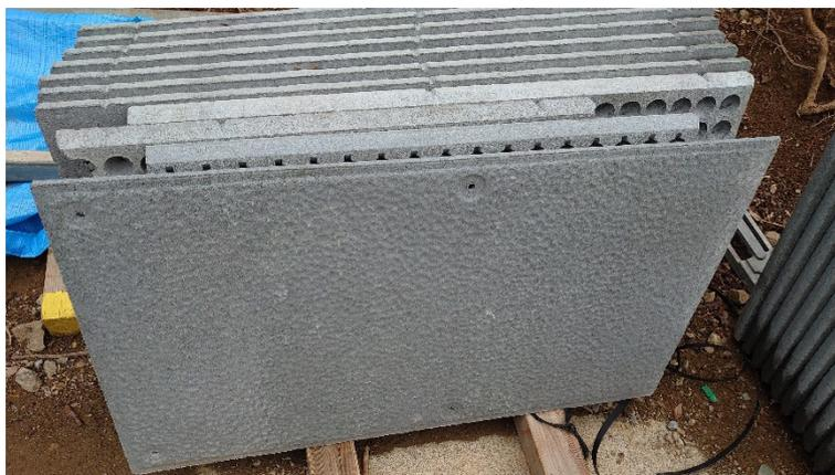
写真-4 残存型枠表側
