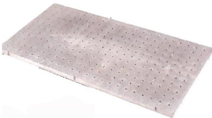
写真-3 残存型枠裏側
