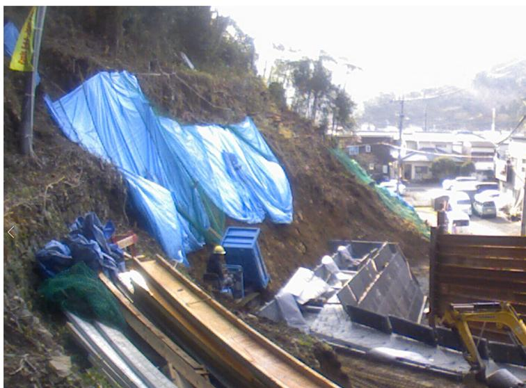
写真-7 擁壁背後の埋戻し作業の状況
