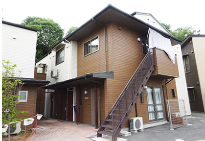
写真1 屋外階段を経由した2階の居室への専用出入口
