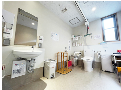
写真17 天井走行式リフトを設置した車椅子利用者用トイレ
