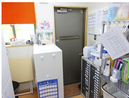
写真2 グループホームのスタッフ室に設けた職員用出入口
