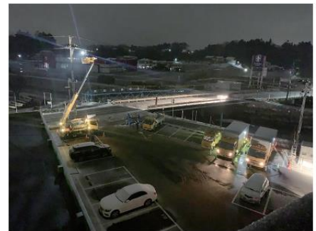
2022.03.18 相馬中央病院：電力切替工事
