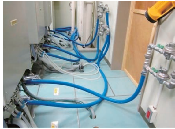
写真2 フレキシブルチューブの使用
