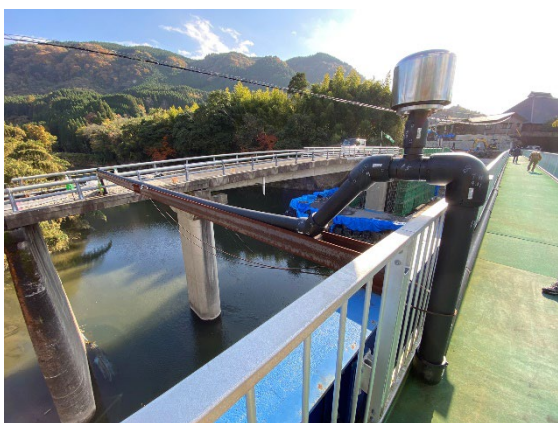
写真-4. 仮設歩廊上への仮設配管（令和4年11月14日現地視察時撮影）
