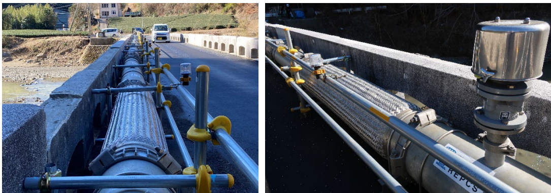
写真-13. 宮嶋橋上に設置されている仮設管（著者ら撮影 令和5年1月30日現地視察時）
