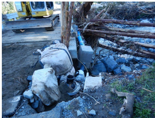
写真-4. 添架管部の管路破損（仙台市水道局提供、令和元年10月15日撮影）
