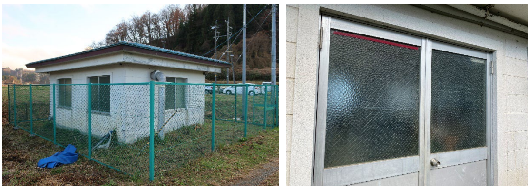
写真-8. 第1水源 復旧状況（令和4年11月21日現地視察時撮影）
