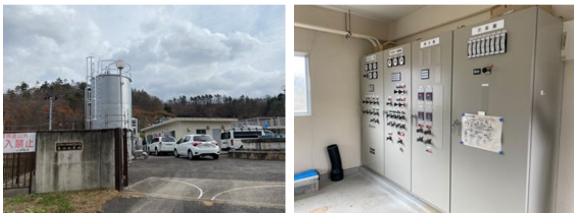
写真-12. 第4水源 復旧状況（令和4年11月22日現地視察時撮影）
