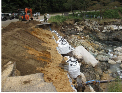
写真-3. 道路崩落による管路露出（仙台市水道局提供、令和元年10月21日撮影）
