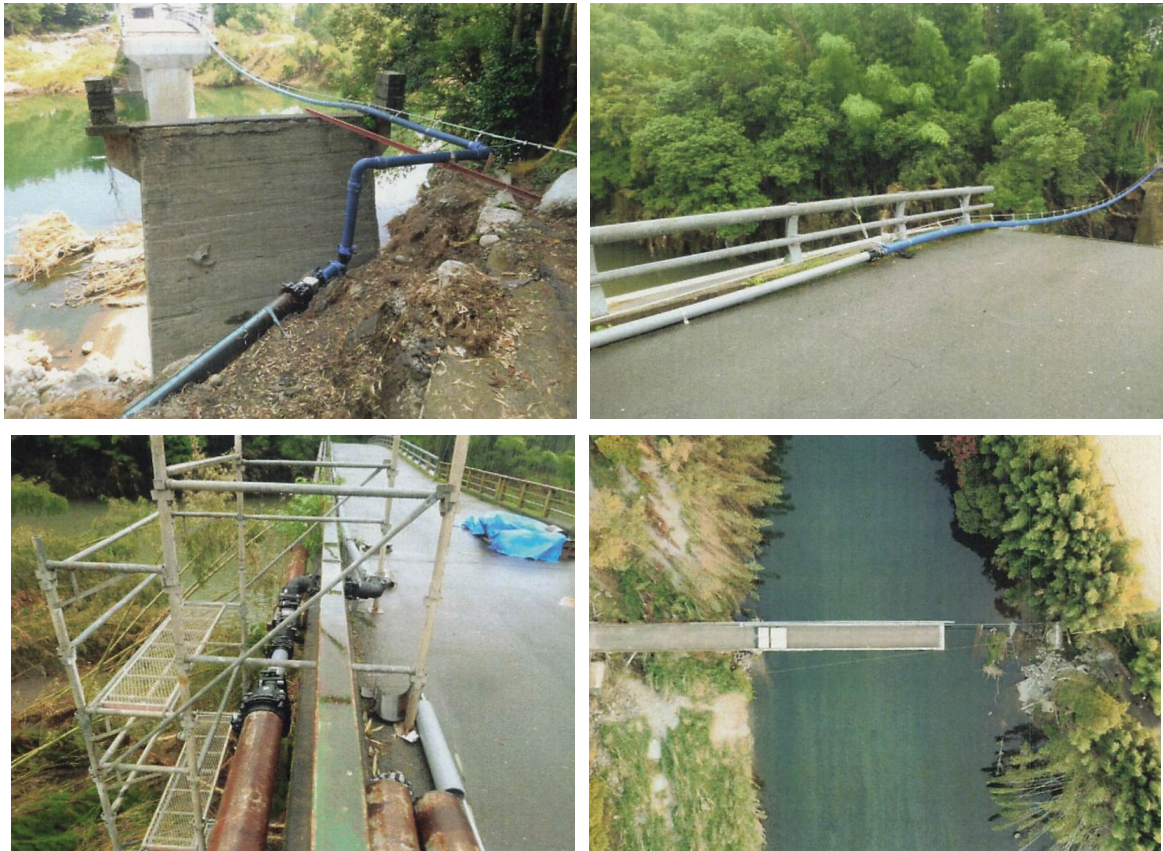
写真-2. 吊り配管施工状況（玖珠町役場提供）
