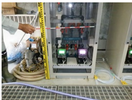
写真-2. 船引浄水場薬注施設 被災状況（田村市上下水道局提供，撮影日不明）
