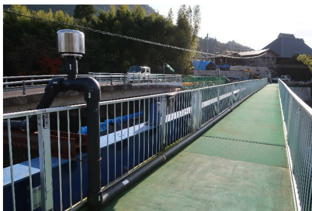
写真-4. 仮設歩廊上への仮設配管（令和4年11月14日現地視察時撮影）
