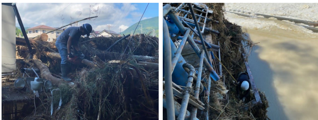
写真-7. 静岡市職員および地元業者による流木等の撤去作業（静岡市上下水道局提供 撮影日不明）
