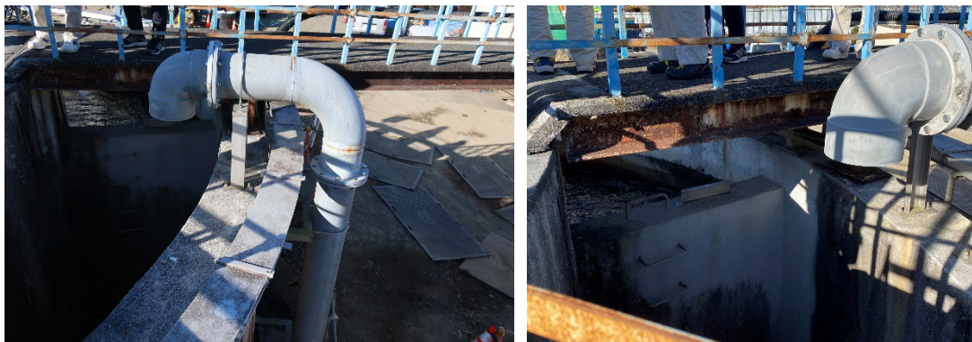
写真-17. 仮設配管部が撤去された工業用水受水部（著者ら撮影 令和5年1月30日現地視察時）
