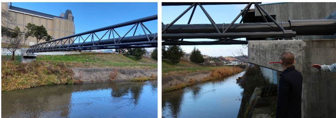
写真-6. 水管橋 復旧状況（令和4年11月21日現地視察時撮影）
