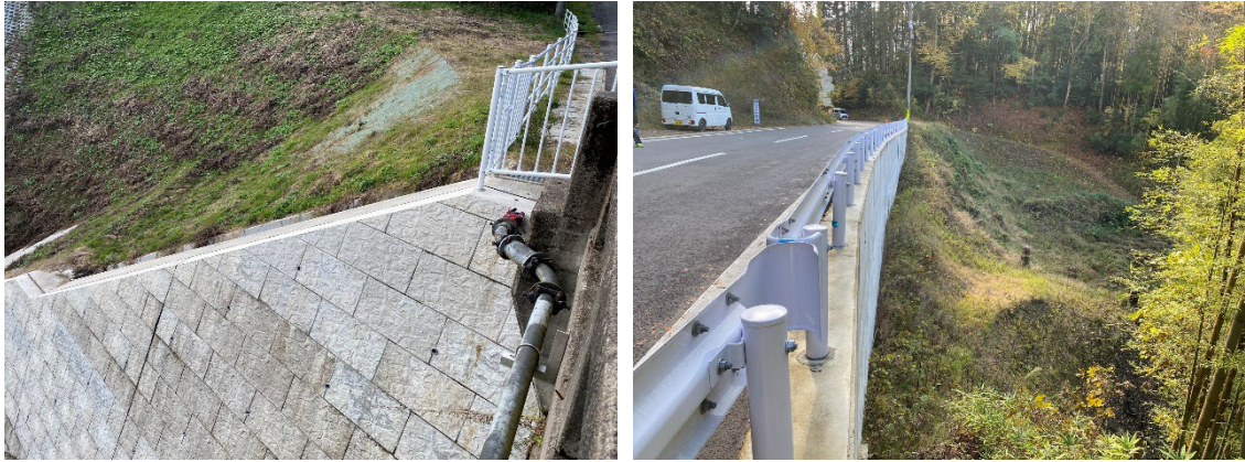
写真-3. 復旧が完了した被災箇所（令和4年11月14日現地視察時撮影）
