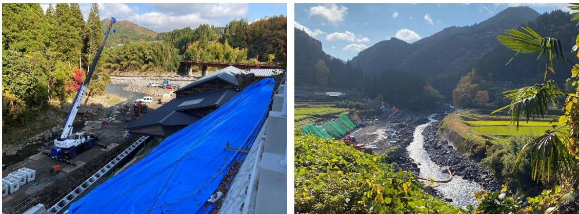
写真-5. 九重町内で進められる河川工事（令和4年11月14日現地視察時撮影）
