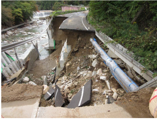
写真-3. 道路崩落による管路露出（仙台市水道局提供、令和元年10月21日撮影）
