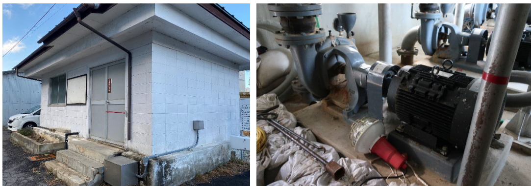
写真-9. 第2水源 復旧状況（令和4年11月21日現地視察時撮影）
