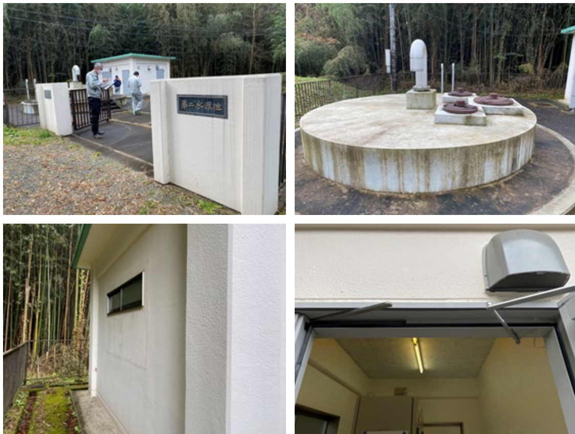
写真-11. 第2水源 復旧状況（令和4年11月22日現地視察時撮影）
