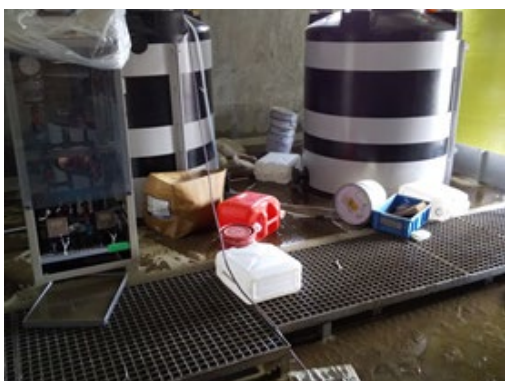
写真-2. 船引浄水場薬注施設 被災状況（田村市上下水道局提供，撮影日不明）
