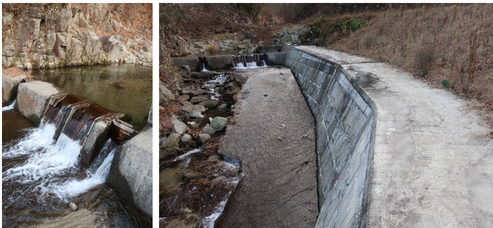
写真-13 黒佐野取水口 復旧状況（令和4年12月9日現地視察時撮影）
