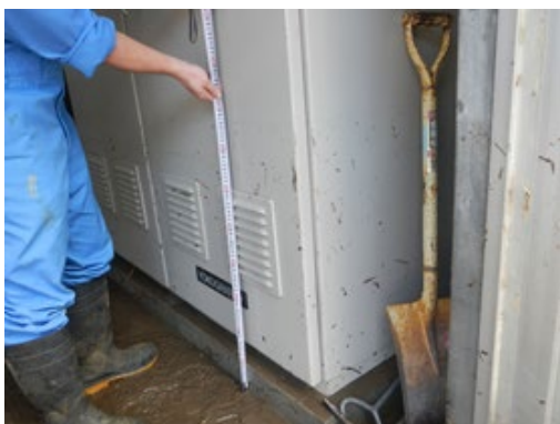
写真-1. 第2水源（庁舎前取水施設） 被災状況（田村市上下水道局提供，撮影日不明）
