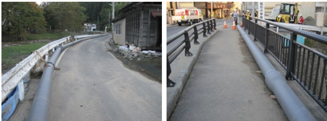
写真-5. 仮設配管 実施状況 (田村市上下水道局提供、撮影日不明)
