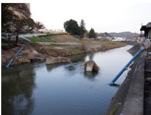
写真-3. 水管橋 被災状況（田村市上下水道局提供，撮影日不明）
