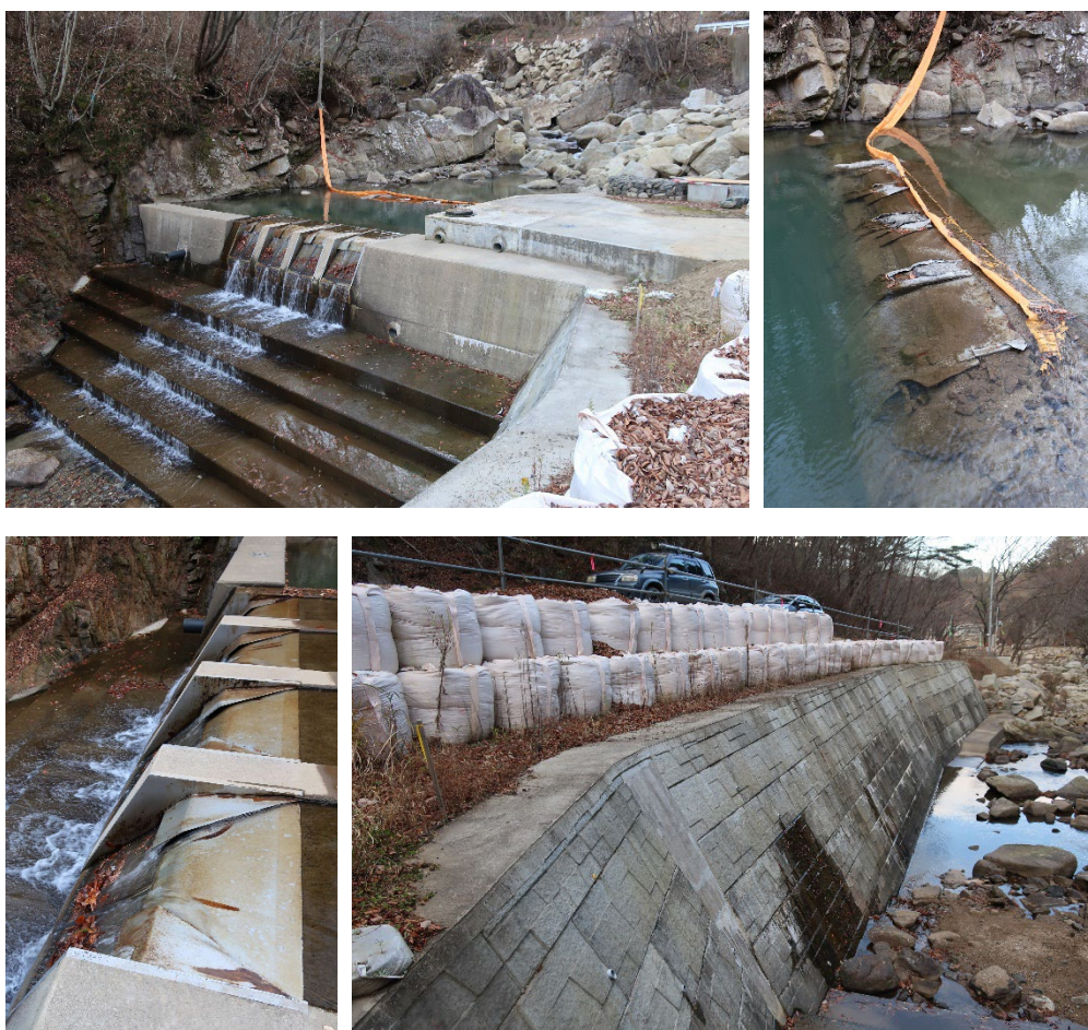
写真-12 鷺ノ平取水口 復旧状況（令和4年12月9日現地視察時撮影）
