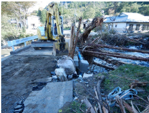
写真-4. 添架管部の管路破損（仙台市水道局提供、令和元年10月15日撮影）
