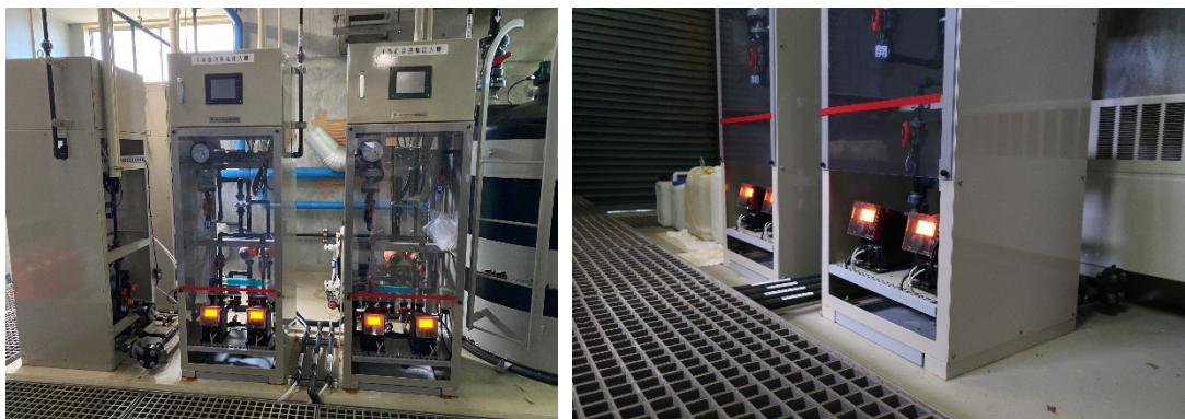
写真-7. 船引浄水場薬注施設 復旧状況（令和4年11月21日現地視察時撮影）
