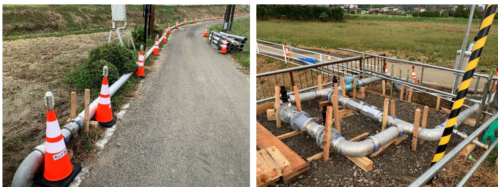
写真-8 角田市との仮設融通管布設状況（仙台市水道局提供 撮影日不明）
