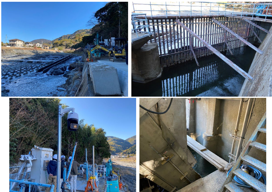
写真-14. 復旧後の承元寺取水口（著者ら撮影 令和5年1月30日現地視察時）
