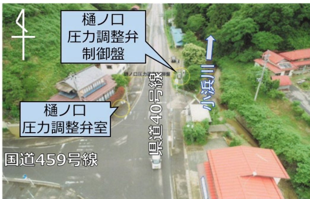
写真-7. 圧力調整弁 航空写真（二本松市役所提供，撮影日不明）
