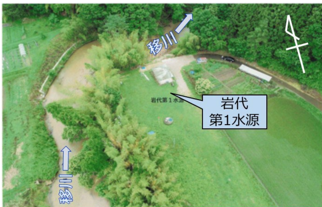
写真-1. 岩代第 1 水源 航空写真（二本松市役所提供，撮影日不明）
