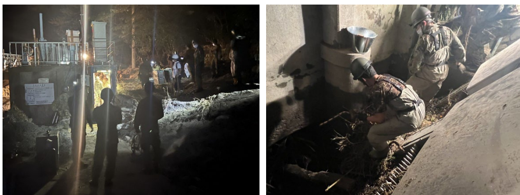
写真-9. 自衛隊による土砂等の撤去作業（静岡市上下水道局提供 令和4年9月27日撮影）
