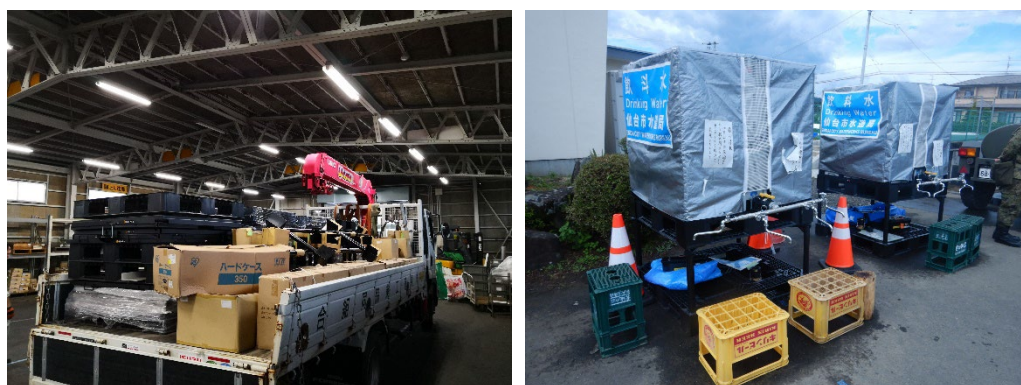
写真-6 仮設水槽の運搬・設置（仙台市水道局提供、撮影日不明）
