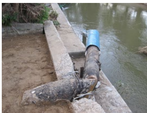
写真-3. 水管橋 被災状況（田村市上下水道局提供，撮影日不明）
