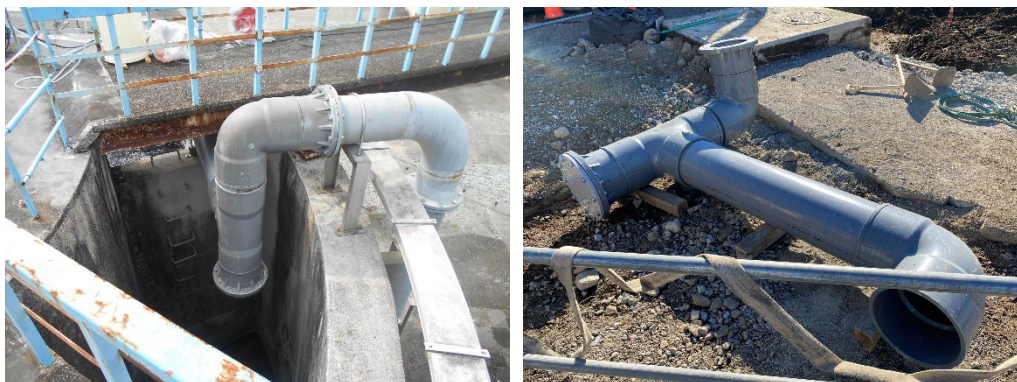
写真-10. 工水受水のための仮設配管状況（左：静岡市上下水道局提供 撮影日不明）および 仮設配管に用いた管材料（右：著者ら撮影 令和5年1月30日現地視察時）
