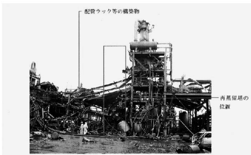
図3 被災後の再蒸留塔近傍
