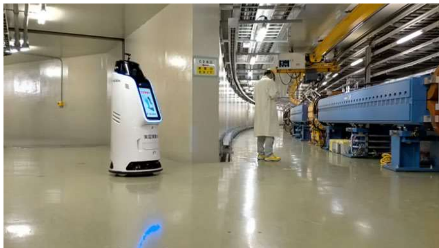
写真-6 REBORG-Zによるメインリング内の自律走行・巡回状況
