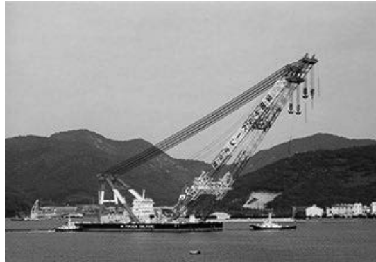
図 23 浮きクレーン
