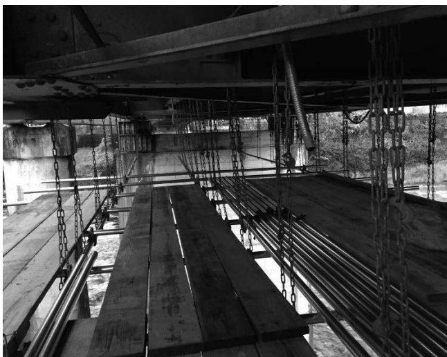
（つり足場の写真） 19
