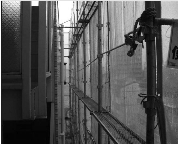
（一側足場の写真） 18
