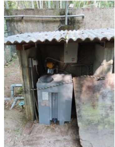
写真 3 塩素貯留槽
