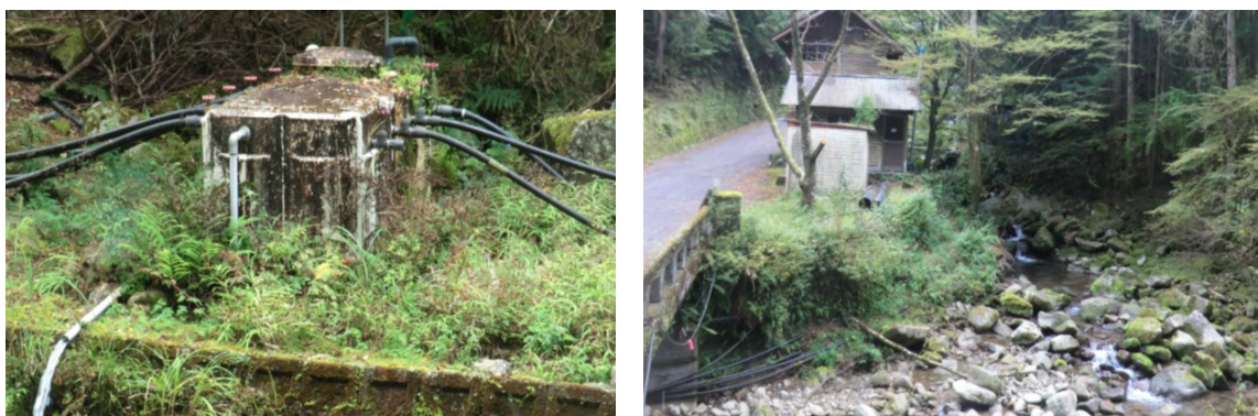
写真 2.2 簡易水道整備前の水道施設の状況 2
