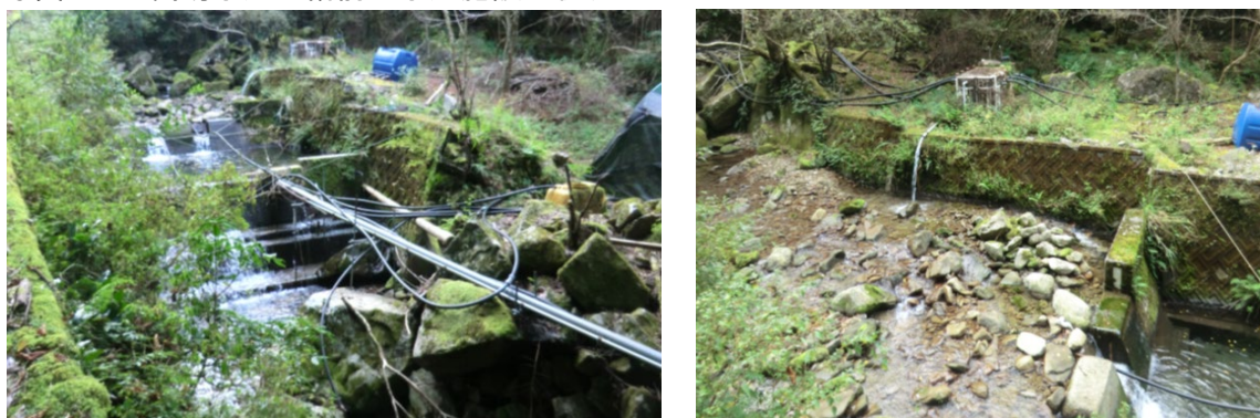
写真 2.1 簡易水道整備前の水道施設の状況 1
