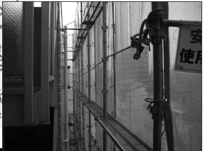
（一側足場の写真） 17
