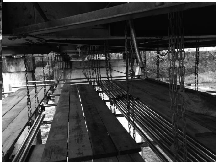
（つり足場の写真） 18
