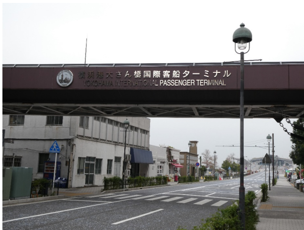
写真2 横浜港大さん橋国際客船ターミナル入り口付近
