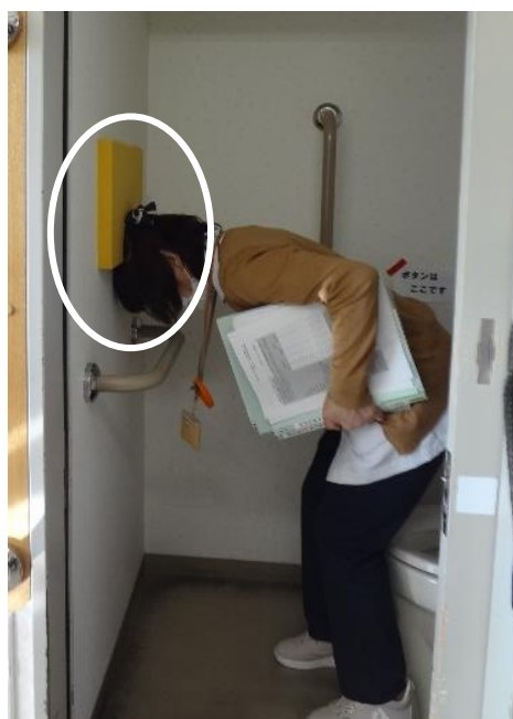
写真5 トイレ内転倒予防の工夫（丸囲み）
