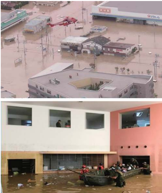
図10 2018年西日本豪雨、まび記念病院の被災状況
