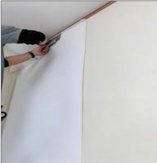
図4. 壁紙施工の様子
