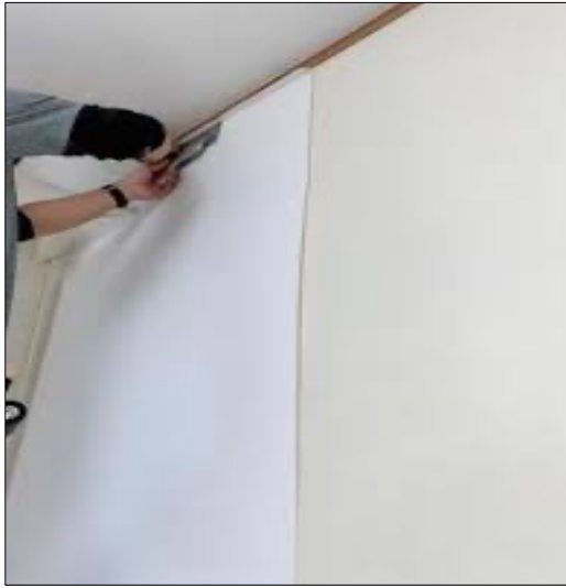
図4. 壁紙施工の様子
