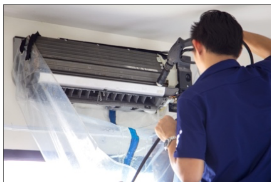
図6. 壁に取付けるタイプのエアコンの清掃の様子
