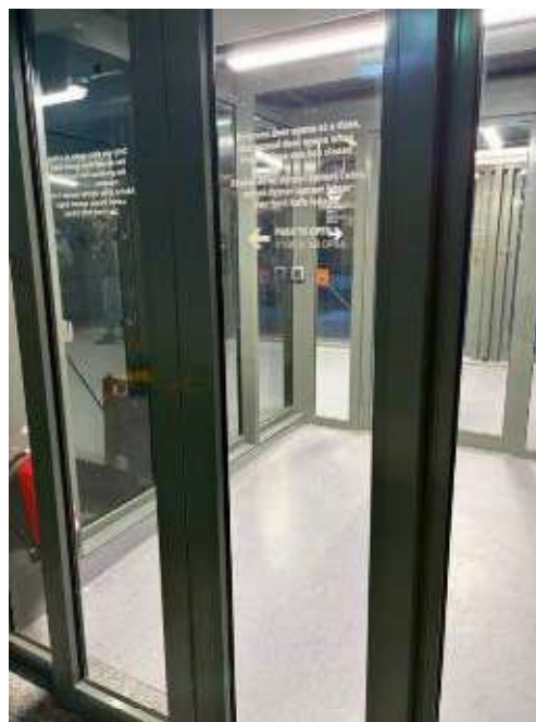
図 13 喫煙室内の様子
