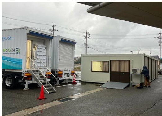
図5 志賀町立富来病院に設置された医療コンテナとフラットパック型コンテナ
