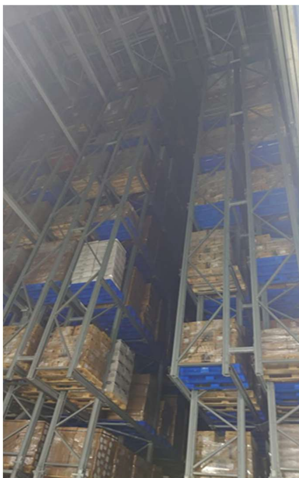
写真3-3：冷凍配送会社内部高さ30mの保管庫：-60℃で維持
