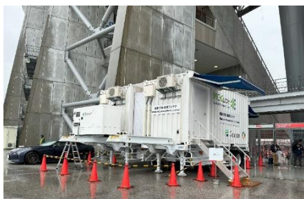
図5 医療コンテナ設置状況
