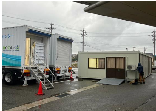
図 5 志賀町立富来病院に設置された医療コンテナとフラットバック型コンテナ
