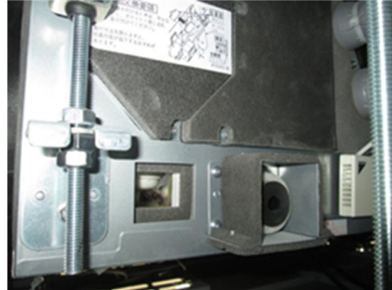
写真2. 4-1 天井内に設置された空調機の例
