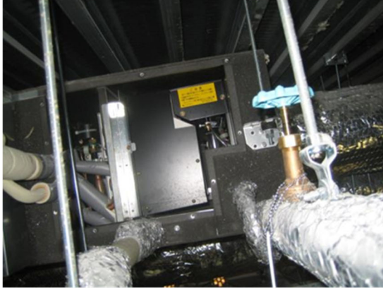
写真2. 4-1 天井内に設置された空調機の例
