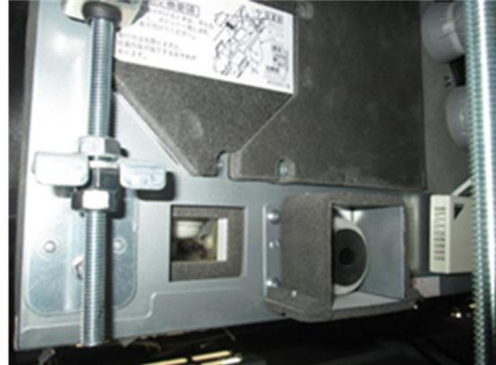
写真2. 4-1 天井内に設置された空調機の例
