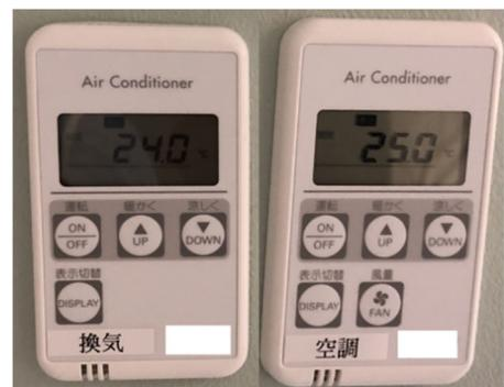
写真2.1-1 換気と空調運転パネル
