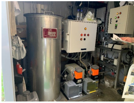
写真5 小規模向け凝集ろ過装置及び水位計を設置した覆蓋
