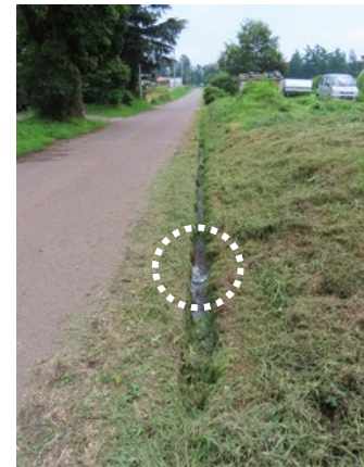
写真 10 水ポンプ作動時の配水池からのオーバーフロー
