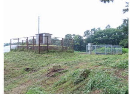
写真 9 新設水源である深井戸
