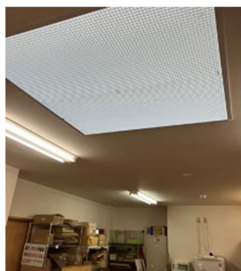
明かり取り窓付き天井
