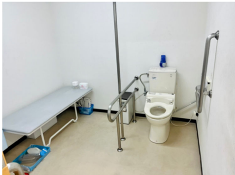
↑幅の広いトイレ
