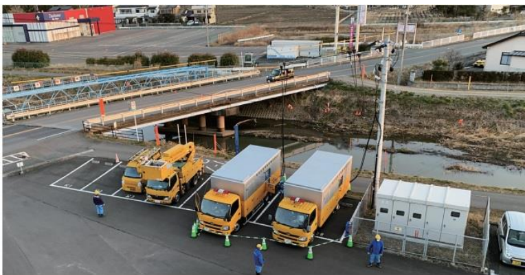
2022.03.17 相馬中央病院における移動電源車の給電活動
