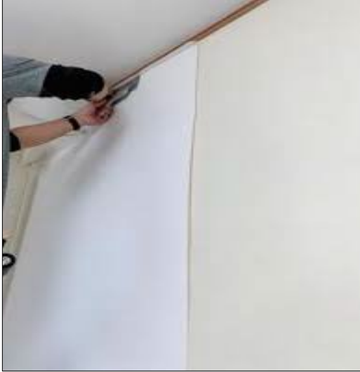
図4. 壁紙施工の様子
