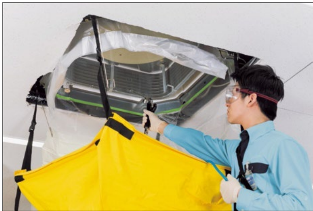
図7. 天井埋め込み式エアコンの清掃の様子
