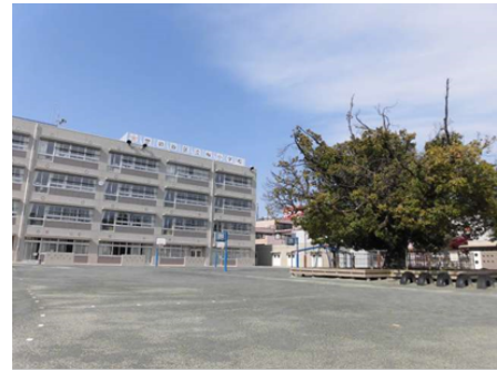
図5 世田谷区立桜小学校外観(桜小学校HPより) 12)
