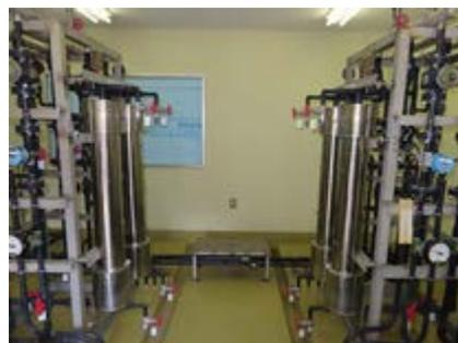
写真 4 猪古里浄水場膜ろ過施設
