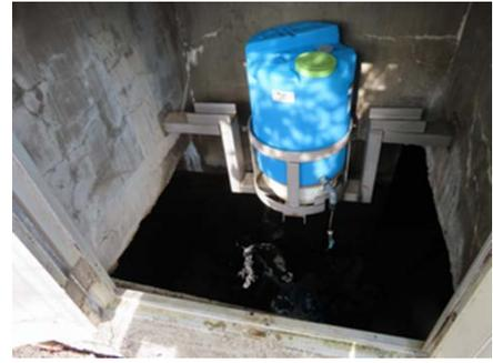
写真2 大和合東村飲料水供給施設 配水池内の塩素注入装置
