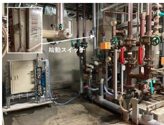
図4 オゾン供給装置設置状況 （ろ過器のオゾン消毒）
