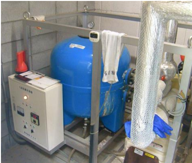
図 2 循環ろ過器 (RUN 1、RUN 2)
